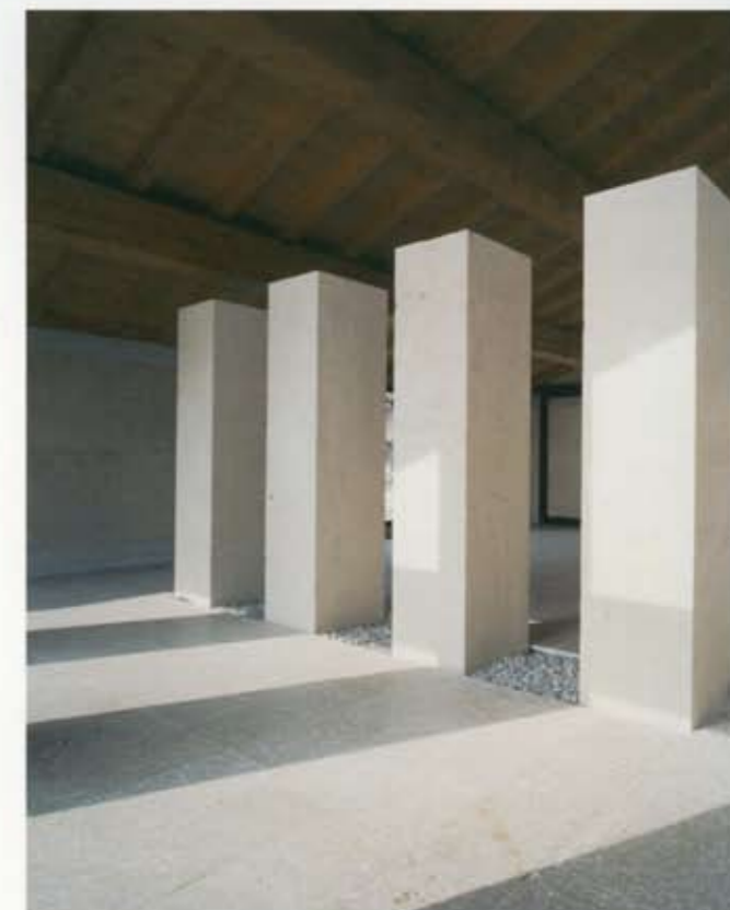
Bricolo Falsarella Associati, Cantina Gorgo, Custoza, Verona 2005, dall'alto: la porta pietrificata all'ingresso della zona vendita, sulla destra l'aia esistente e sullo sfondo il grande Leccio; vista interna del portico, la nuova parete lignea in larice spazzolato contrapposta alla nuova parete in pietra; vista interna della zona vendita con i quattro monoliti 60x60x250 in pietra di Vicenza. A pag. 47: la porta pietrificata all'ingresso della zona vendita. Fotografie: Alessandra Chemollo.
